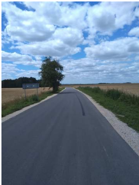
Fot.8 Zmodernizowana droga w Szymanowie
